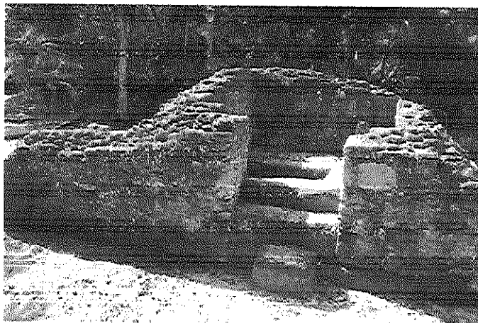
Foto 6. Edificio C, Topoxte, visto desde el Edificio A
