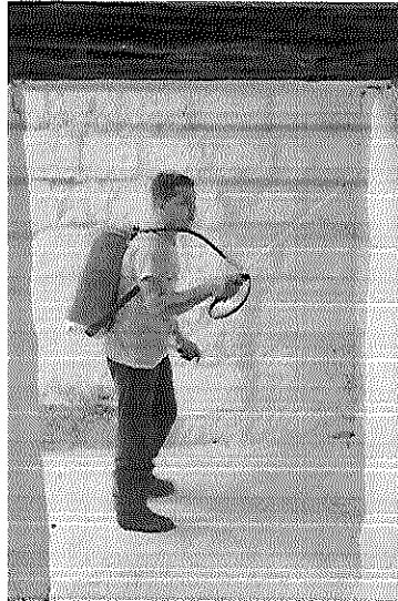
Foto 2. Aplicación de agua de cal, Edificio 375, Acrópolis Sur, Yaxha
