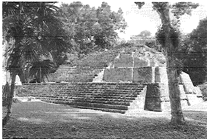
Foto 3. Edificio 4, Grupo Maler, Yaxha
